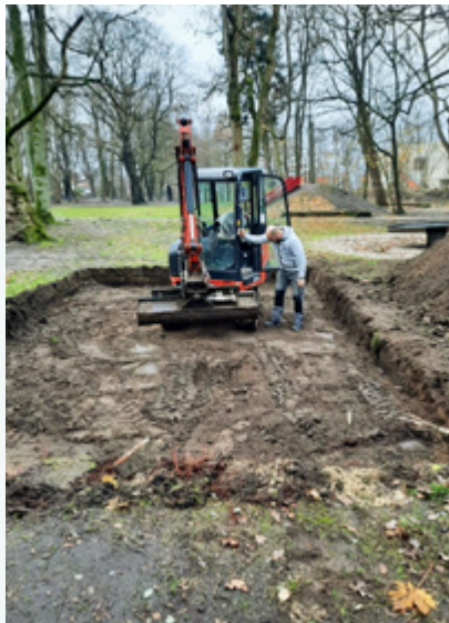
Die Baggerarbeiten für die neuen Schaukeln beginnen Foto: Kay-Ole König
